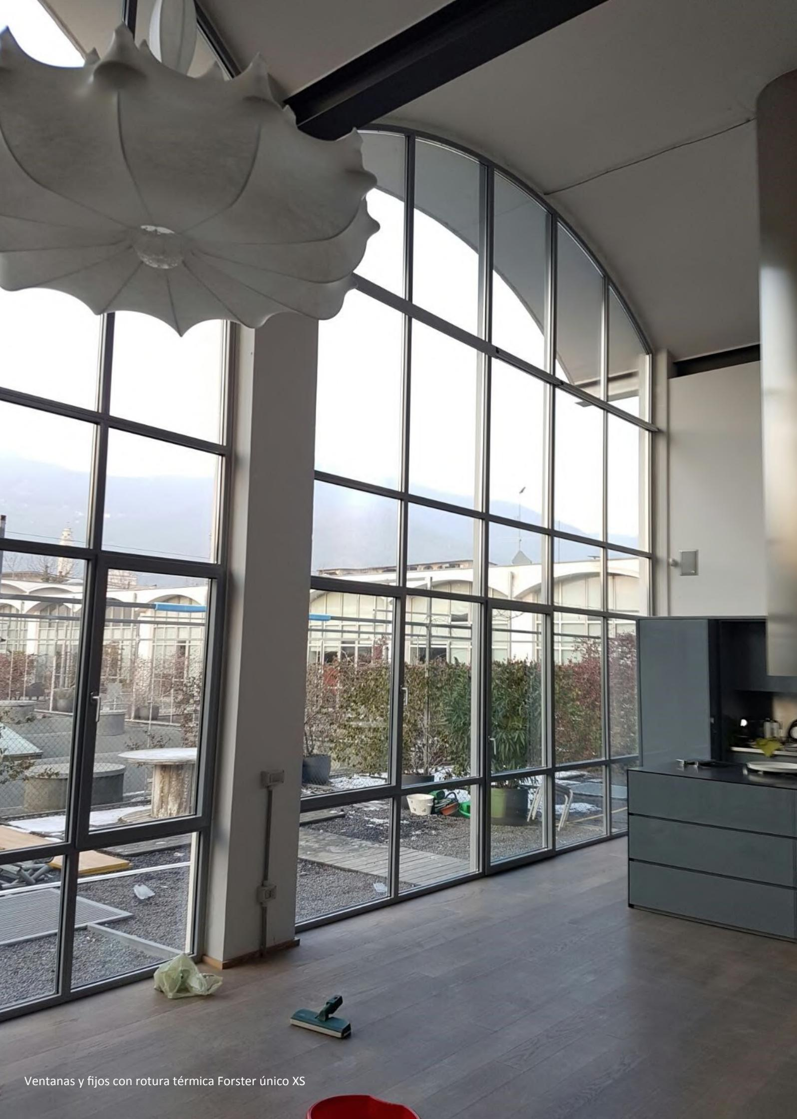
Ventanas y fijos con rotura térmica Forster único XS
